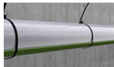
Les chauffages de gouttières et de canalisation Halmburger ne contiennent aucune pièce d'usure et ne nécessitent donc aucun entretien – un avantage particulier de ces systèmes de chauffage !
